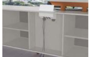
A furação para passagem de fios deverá ser realizada na hora da montagem, nas costas ou base, conforme necessidade.
